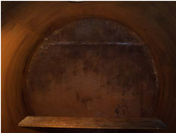
Préparation de la cuve : Raclage et meulage des arrêtes vives
