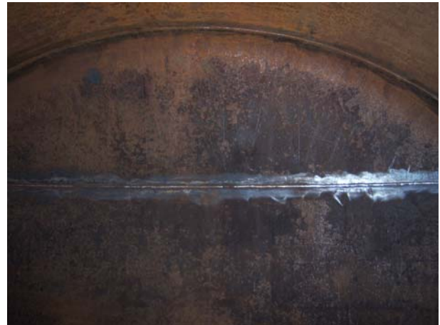
Préparation de la cuve : Raclage et meulage des arrêtes vives
