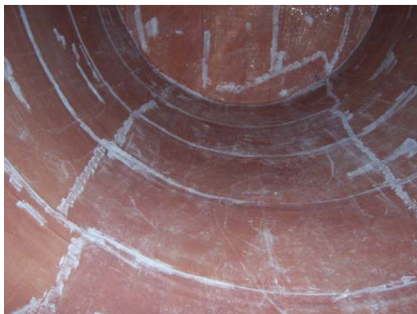
Pose d'un complexe stratifié résine renforcée de fibres de verre, comprenant une couche de tissu de verre 450 \text{ g/m}^2 , épaisseur finie 0,8 \text{ mm} et une résine époxy appliqué au rouleau.
