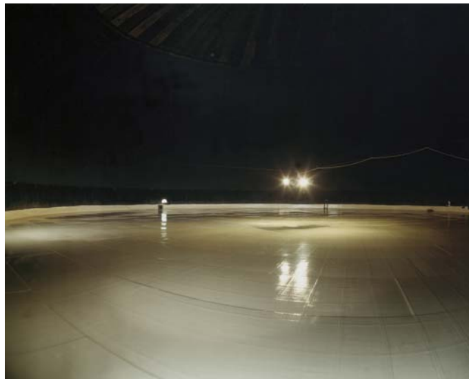
Passivation de la paroi par application d'un revêtement époxy bi composants épaisseur finie 0,7 mm.
