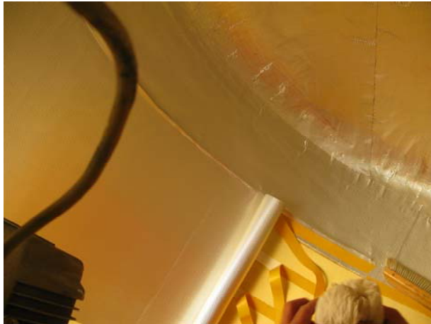
Pose d'un profilé aluminium faisant fonction d'espace interstitiel de contrôle
