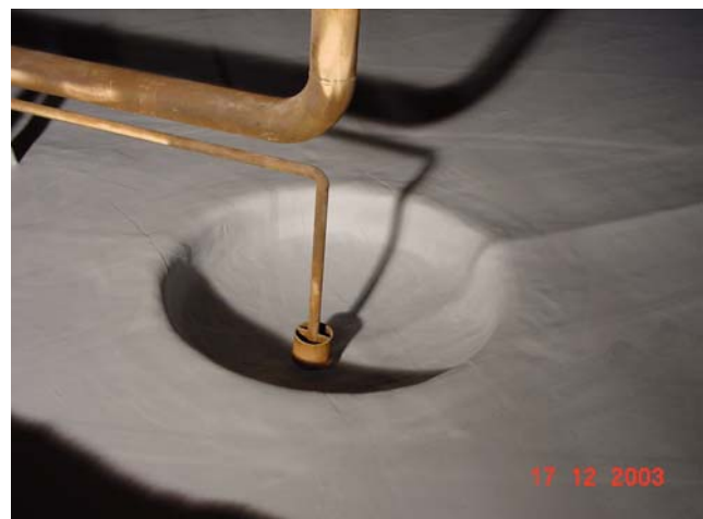
Application d'un revêtement époxy bi composants anti-statique et Etat final
