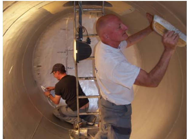
Pose d'un profilé aluminium faisant fonction d'espace interstitiel de contrôle
