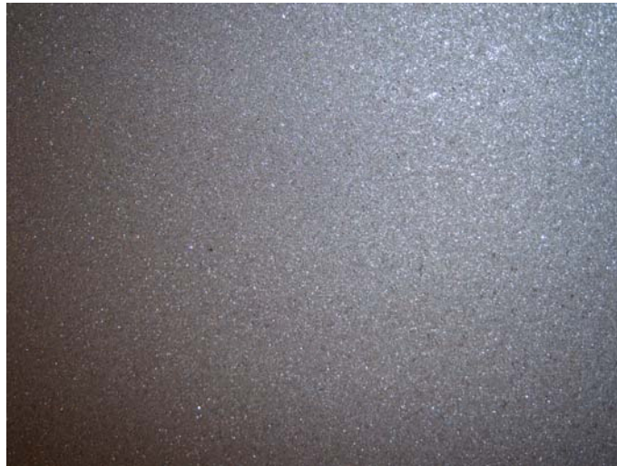
Décapage et préparation de la paroi par sablage SA 2,5.
