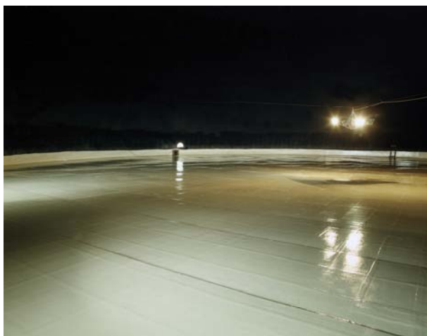
Application d'un revêtement époxy bi composants anti-statique et Etat final
