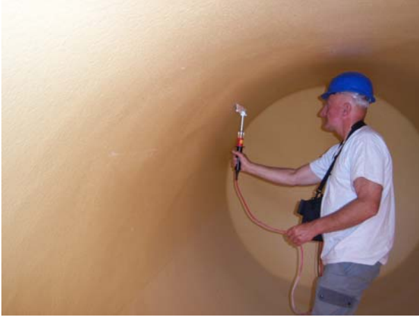
Vérification de l'étanchéité de la stratification au détecteur de porosité, et mesure d'épaisseur du revêtement.
