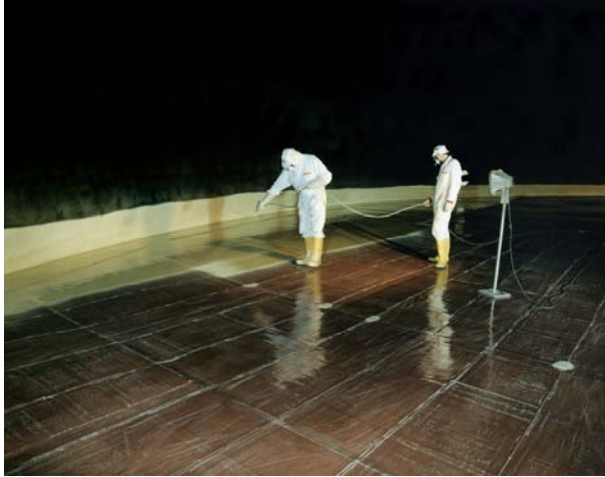
Projection d'un revêtement époxy bi composants, épaisseur finie 0,7 mm.
