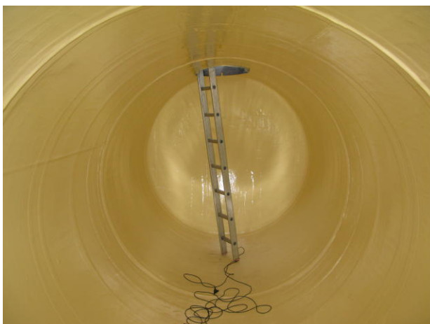
Projection d'un revêtement époxy bi composants, épaisseur finie 0,7 \text{ mm} .
