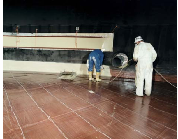
Projection d'un revêtement époxy bi composants, épaisseur finie 0,7 mm.
