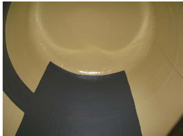
Vérification de l'étanchéité de la stratification au détecteur de porosité, et mesure d'épaisseur du revêtement.
