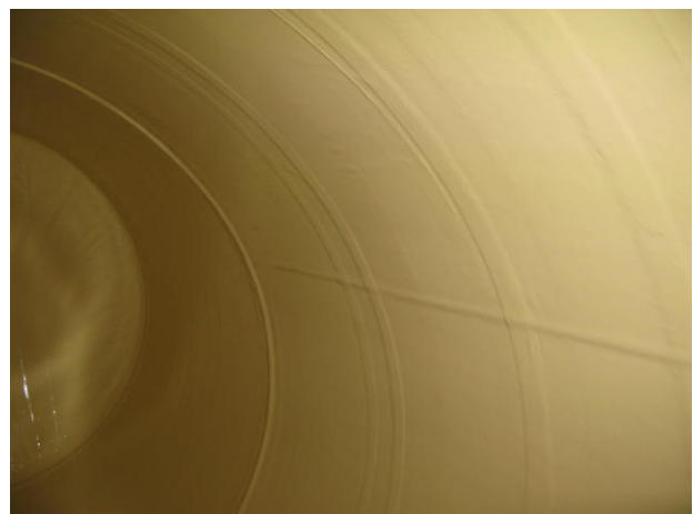
Projection d'un revêtement époxy bi composants, épaisseur finie 0,7 \text{ mm} .
